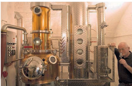
Die «dicke Berta» macht's möglich: Der gebürtige Churer Georg Schenk hat in seinem Anwesen vor Dresden die modernste Brennanlage Europas montieren lassen.
